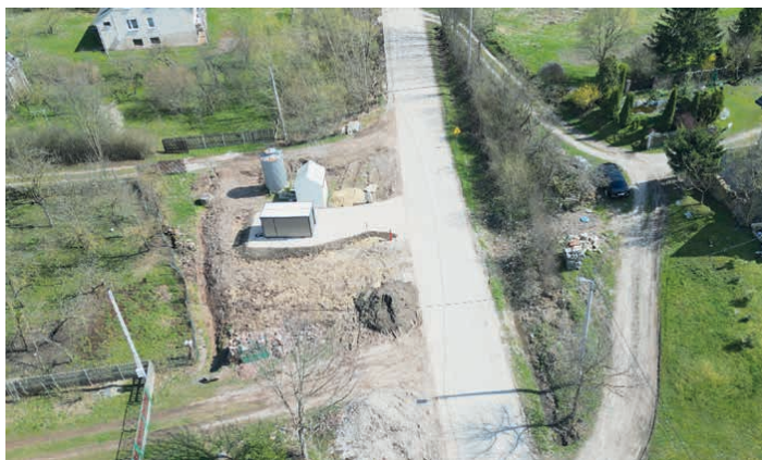
Oprócz nowej nitki wodociągowej powstała m.in. nowoczesna pompownia. (fot. BCK)
