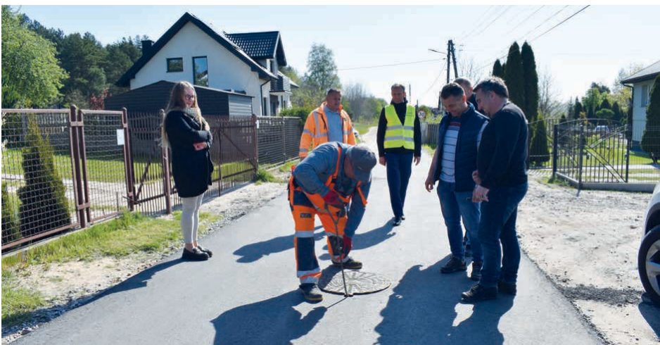
Kanalizacja i droga w Janowie już po odbiorze technicznym. Mieszkańcy Janowa mogą się cieszyć komfortowymi warunkami życia. (fot. BCK)
